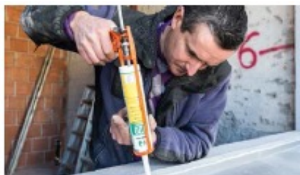
11 MONTARE IL DAVANZALE FINESTRA ESTERNO
