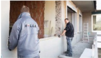
1 MISURARE L'APERTURA DELLA MURATURA
