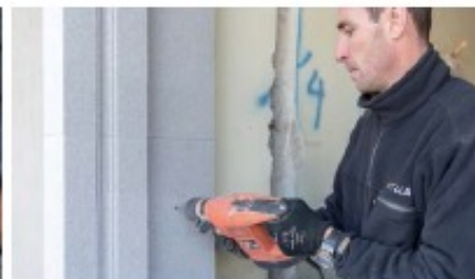
9 ESEGUIRE LA FORATURA NEL MURO
